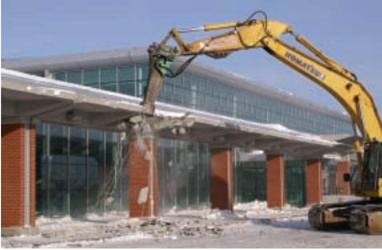
Début des travaux; démolition de la marquise, 8 février 2007
