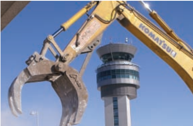
Travaux de démolition en cours, 13 février 2007
