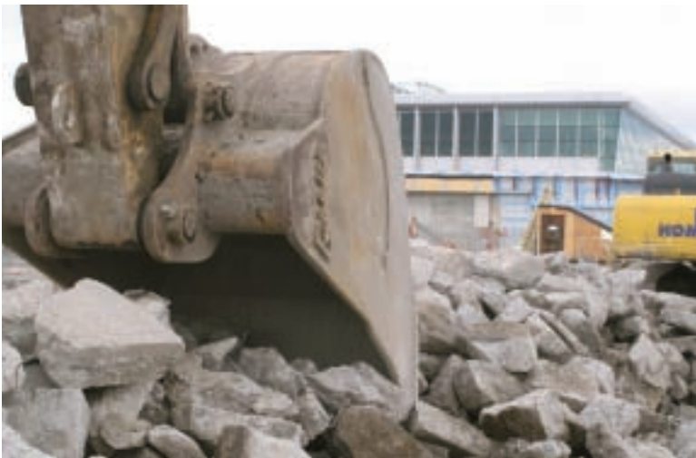
Travaux de démolition en cours, 23 mars 2007
