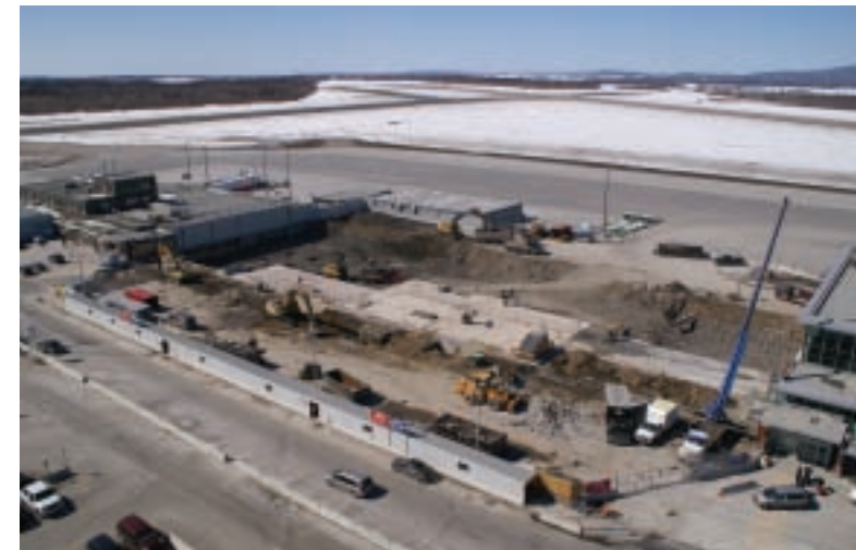
Démolition de l'aérogare vue de la tour de contrôle, le 28 mars 2007
